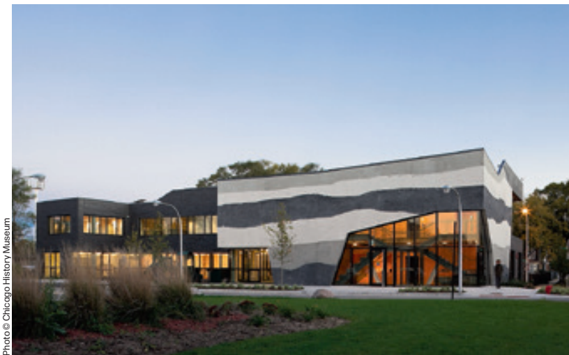
Sopra: la facciata "a strati" del Lavezzorio Community Center è realizzata con cemento ricevuto in dono Above: the "strata" wall of the Lavezzorio Community Center was cast with donated concrete
